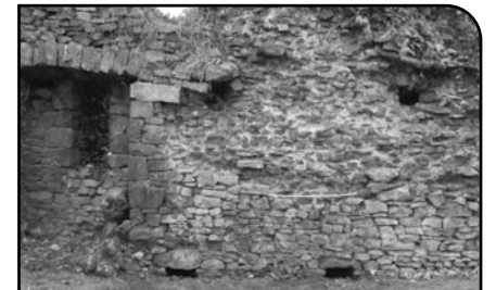
Face intérieure du rempart ouest. Au ras du sol, les trous de boulin dégagés, de même que les plus petits deux mètres plus haut.
