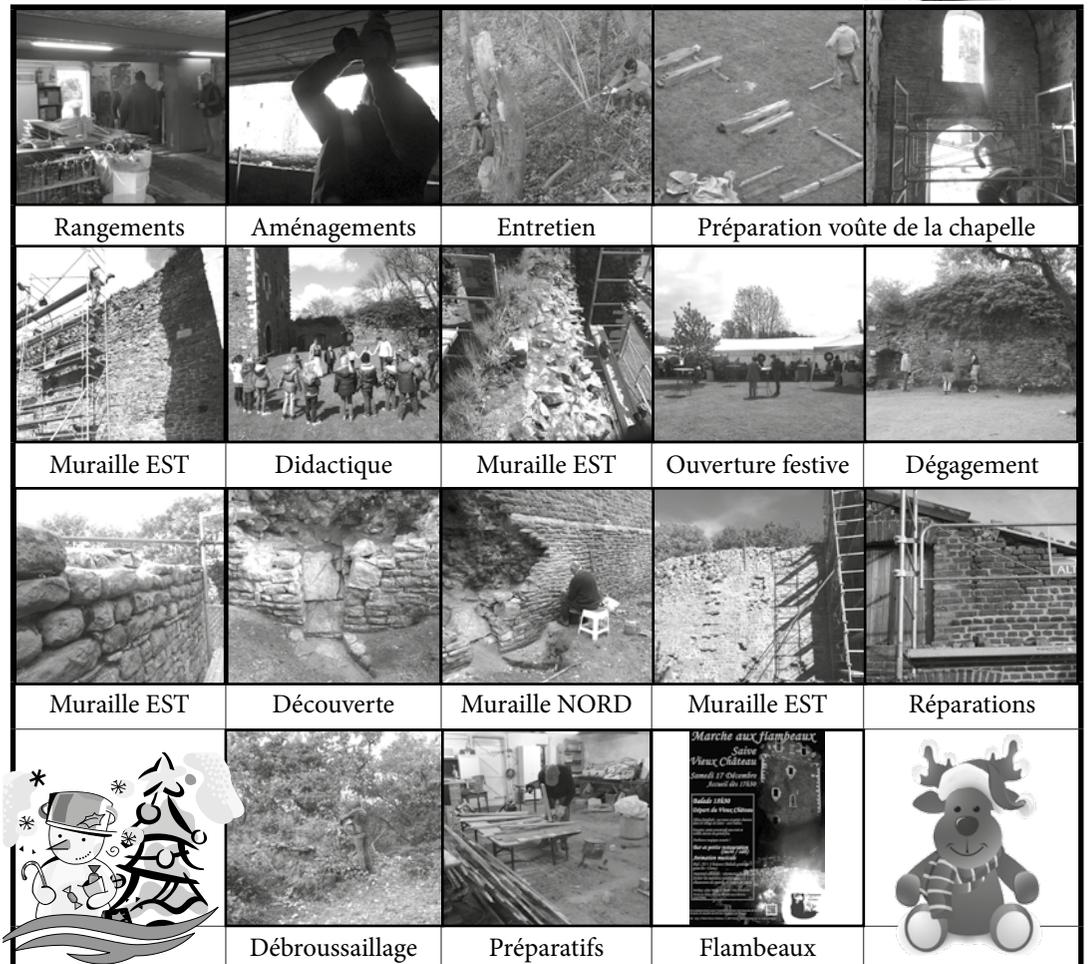
On s'aperçoit au travers de ces quelques images que le gros chantier de cette année a été la muraille EST. Le parement du côté haute-cour ne semble pas d'origine et il a disparu à de nombreux endroits (photo 6-8-14). Côté courtine EST, l'appareillage est plus ancien mais d'une très bonne qualité (photo 11).
